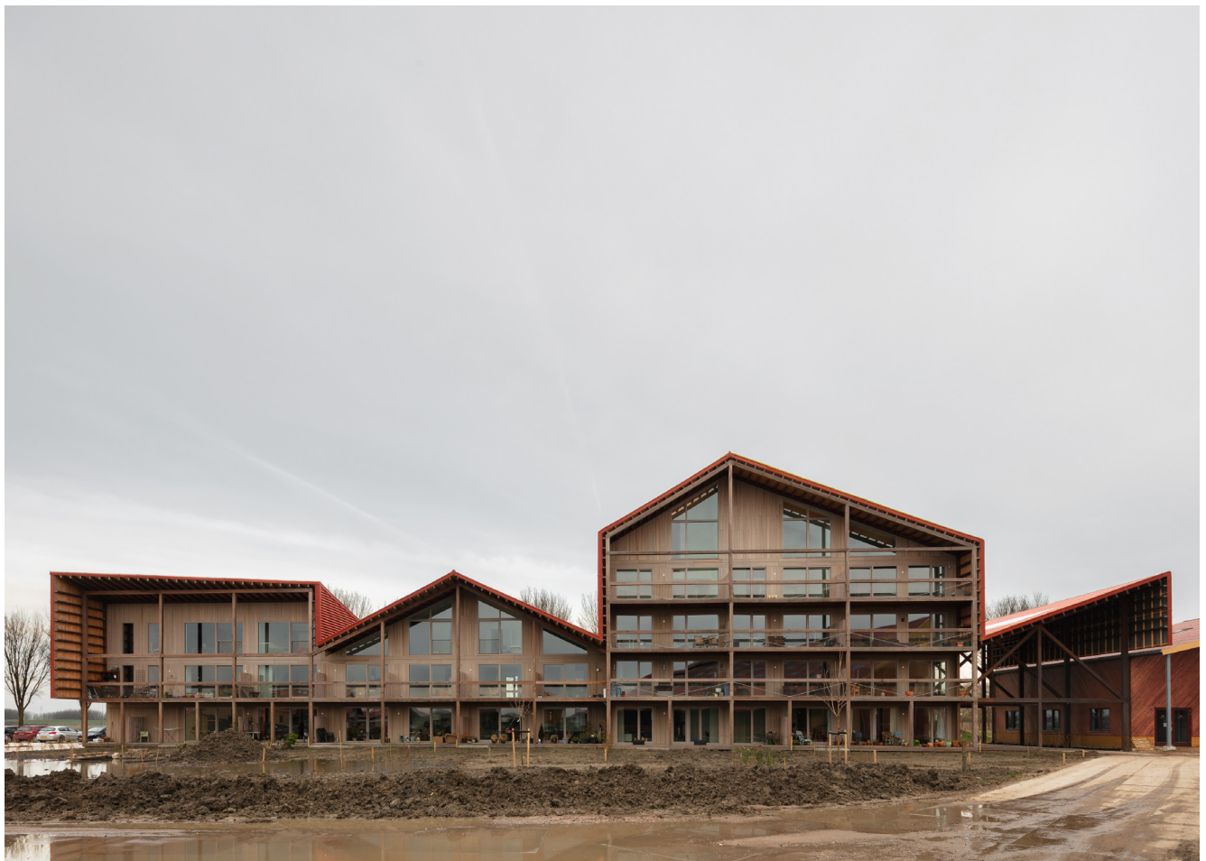
Balkons aan de erfzijde
